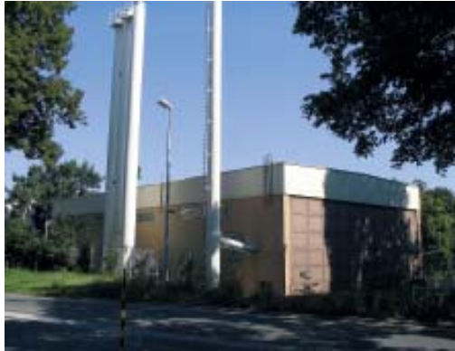
Das gasbefeuerte Heizwerk an der Vacher Straße versorgte die Monteith-Gebäude mit Wärme.
